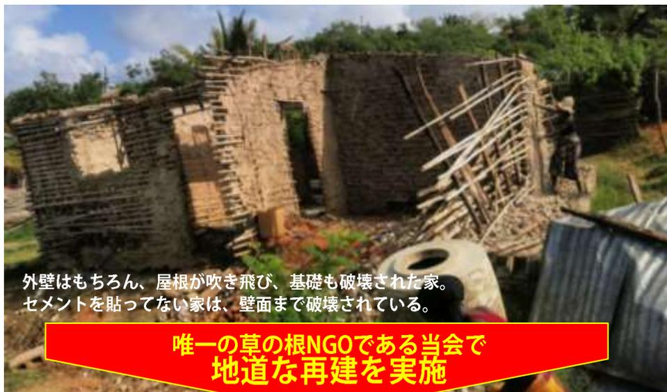
外壁はもちろん、屋根が吹き飛び、基礎も破壊された家。セメントを貼ってない家は、壁面まで破壊されている。
