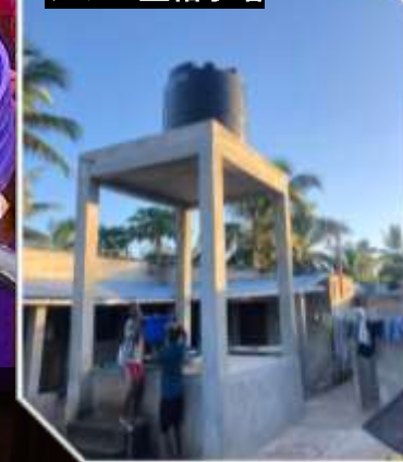
タワー型給水塔
